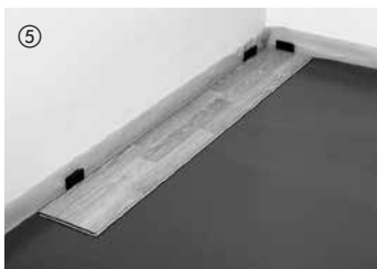
⑤ Comenzando por la esquina derecha de la habitación, los elementos con el lado de la lengüeta se colocan hacia la pared y se fijan con cuñas distanciadoras (distancia de dilatación con respecto a la pared de 10–15 mm).
