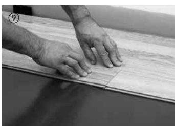
⑨ A continuación el elemento se baja por el frente. A este respecto, asegúrese de que el elemento tope a ras por el frente con el elemento instalado previamente. Presionando brevemente en la junta transversal, el elemento se encaja.
