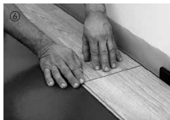
⑥ Los demás elementos de la primera fila se ensamblan desde arriba en la lapa previa por los extremos del cabezal. Presionando brevemente sobre la junta transversal, el elemento se encaja en el elemento de al lado. Asegúrese de que los elementos estén perfectamente alineados. El último elemento de la primera fila se corta considerando la distancia de dilatación de 10 a 15 mm con respecto a la pared, y entonces se ensambla.
