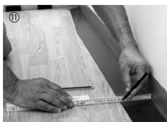
⑪ Las planchas de la última fila se deben cortar y ajustar longitudinalmente teniendo en cuenta que se ha de dejar una distancia de dilatación de 10 a 15 mm.
