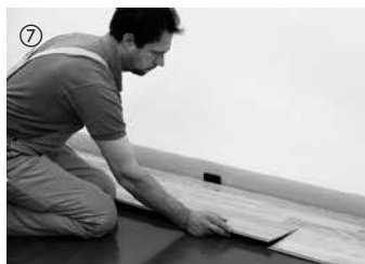
⑦ Con la pieza sobrante de la primera fila se vuelve a empezar en la siguiente fila (desplazamiento frontal de al menos 50 cm). Gracias a esto se reducen considerablemente los desperdicios. La instalación se realiza ahora elemento por elemento. Primero se introducen los elementos lateralmente ejerciendo una ligera presión en la unión.
