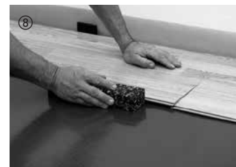
⑧ En caso necesario, reparar suavemente con un taco para golpear.
