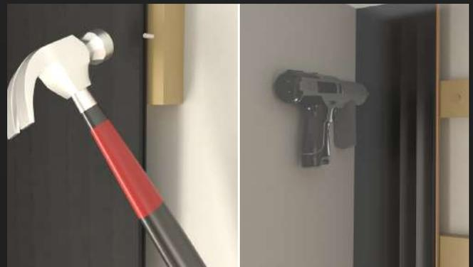
3. Ir uniendo las lamas, el macho con la hembra, y clavando o clipando la otra parte de la lama.
